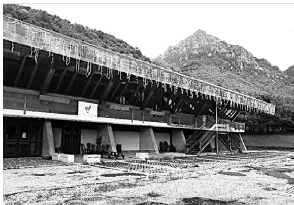
Fig. 4. Il palaghiaccio di Ussita (MC), attualmente in stato di abbandono.
