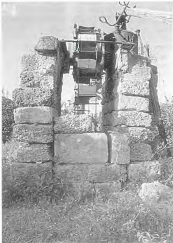
FIG. 1 Noria del tipo Gatteaux con ingranaggi protetti.
