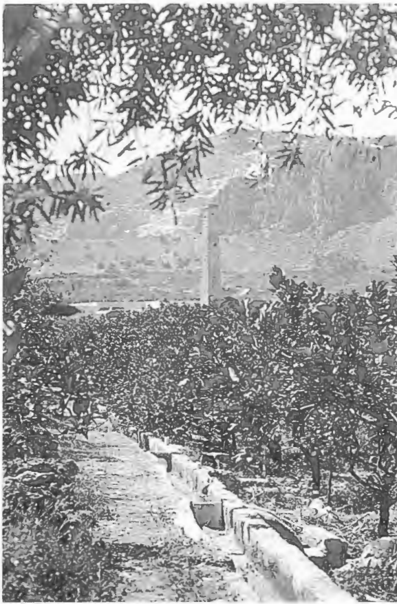
FIG. 3 «Saia» che provvede all'irrigazione di un limoneto. Sullo sfondo l'imponente mole del «castelletto» principale di una macchina d'acqua.
