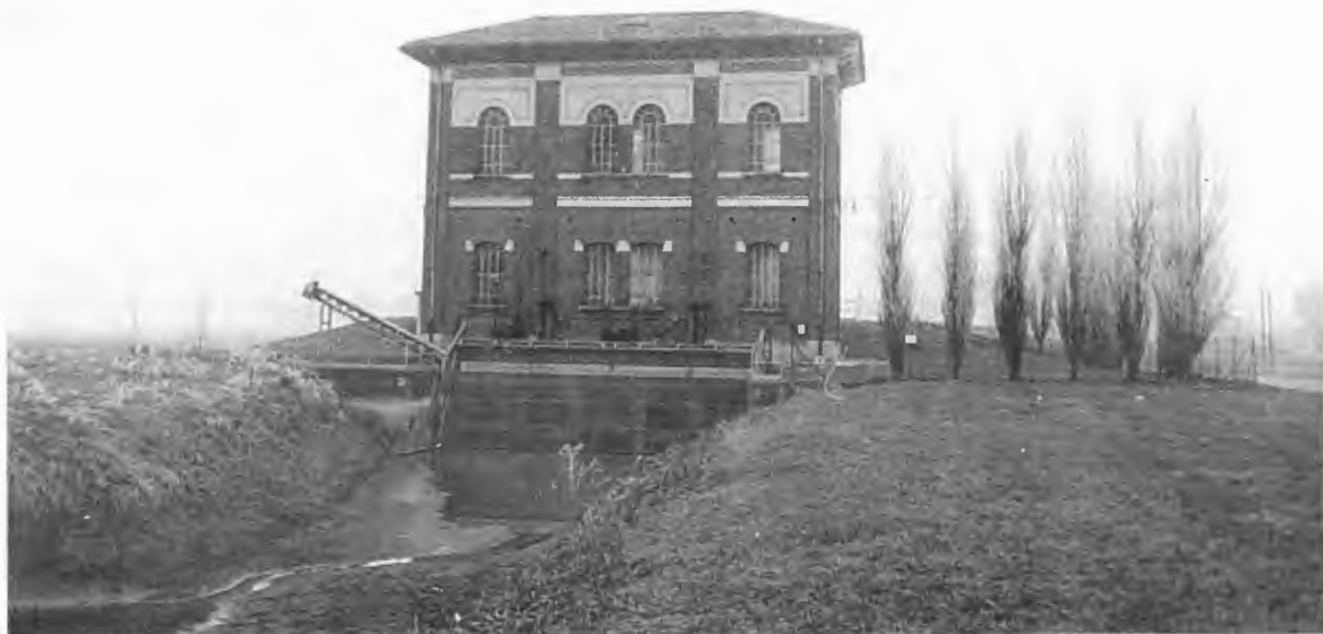
FIG. 3. Un impianto di sollevamento nelle campagne di Carpi, nell'ambito del Consorzio della bonificazione Parmigiana Moglia.
