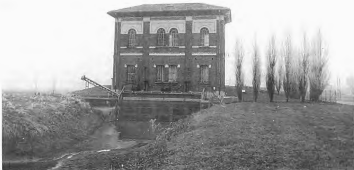
FIG. 3. Un impianto di sollevamento nelle campagne di Carpi, nell'ambito del Consorzio della bonificazione Parmigiana Moglia.
