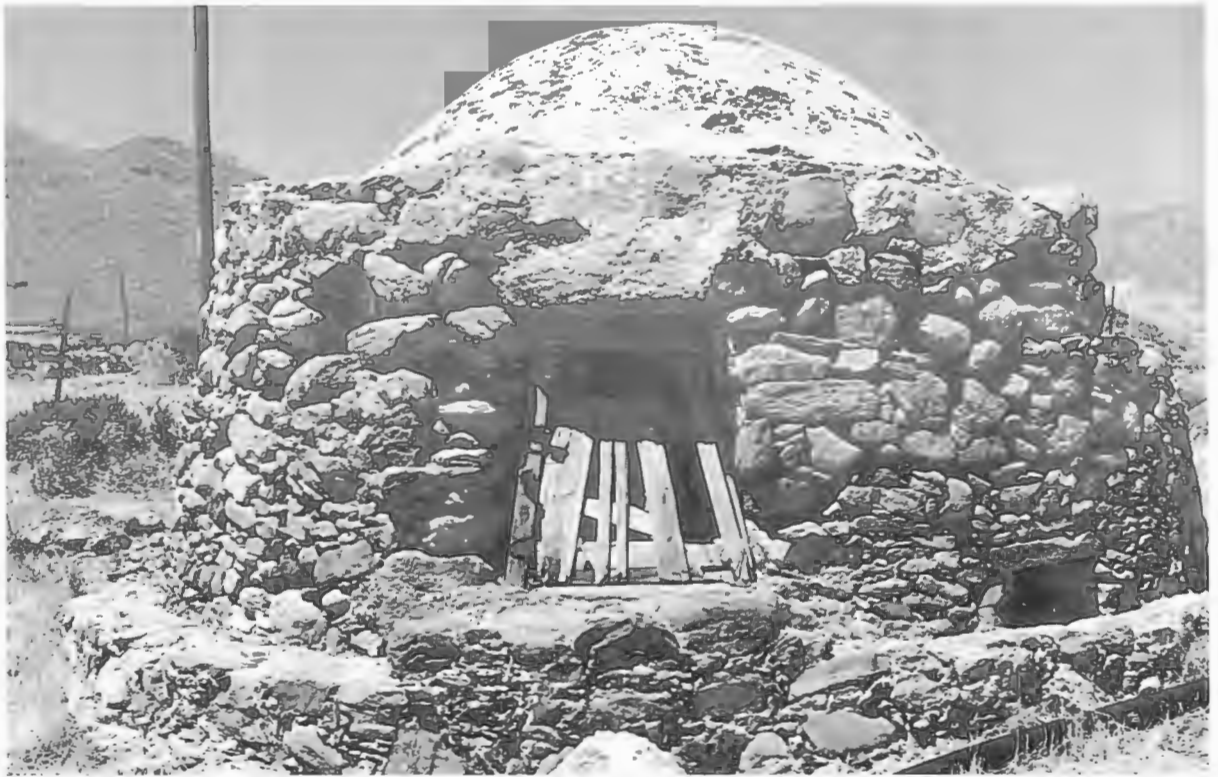
Fig. 2 (a) In alto al centro: costruzione a pianta circolare con volta a cupola (Creta Orientale) (Foto Kunalakis M.); (b) in basso a sinistra: tipica casa cretese in pietra a secco, sviluppata su due piani (Fodele) (Foto Cassimatis M.); (c) in basso a destra: particolare di un muro di cinta in pietra a secco (Fodele) (Foto Cassimatis M.)
