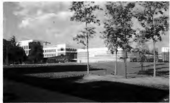
Fig. 3. Veduta attuale dell'area ex-Cotonifici Cantoni. (Foto Monica Morazzoni).
