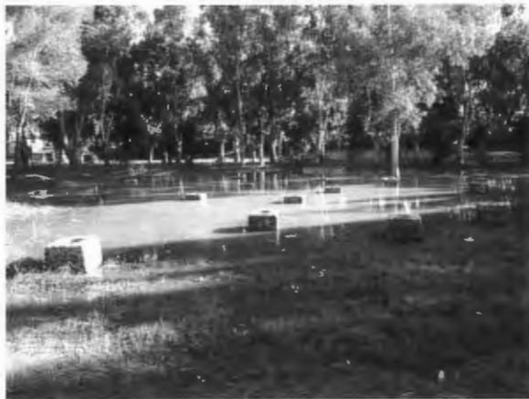
Fig. 2. CASTRIGNANO DE' GRECI (Le): pozzelle. I pozzi (*ta fr̄ata*), raggruppati in una grande depressione di origine carsica, sono scavati nella roccia friabile e sono rivestiti con pietre di calcare permeabile disposte in cerchi concentrici fino a formare una cupola profonda da 3 ai 6 metri. Ciascuna "pozzella" è coperta da un monolito parallelepipedo forato al centro, detto *puteàle* o *uccalè*. (foto: A. Zacheo)
