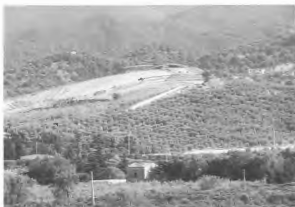
Fig. 2. Valle del Trionto (Sila Greca). Pendio in corso di sistemazione a girapoggio e cavalca poggio.
