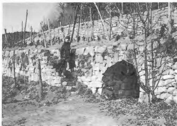
Fig. 1. Terrazzamento vitato con scala in testa al muro e arco cavo a tutto sesto (fonte: foto G. Carosso).
