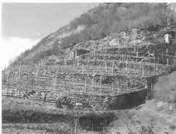
Fig. 6. Chiomonte. Terrazzamenti in ottimo stato di manutenzione coltivati a vigneto, in località Maddalena, alle pendici della frazione Ramats. I vigneti assecondano le curve di livello, e i muretti sono raccordati da gradoni aggettanti, costituiti da lose.
