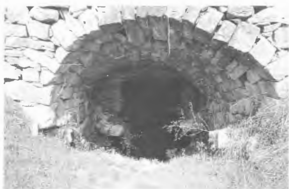
Fig. 2. Arco cavo a tutto sesto con all'interno cisterna per la raccolta dell'acqua (fonte: foto dell'autore).
