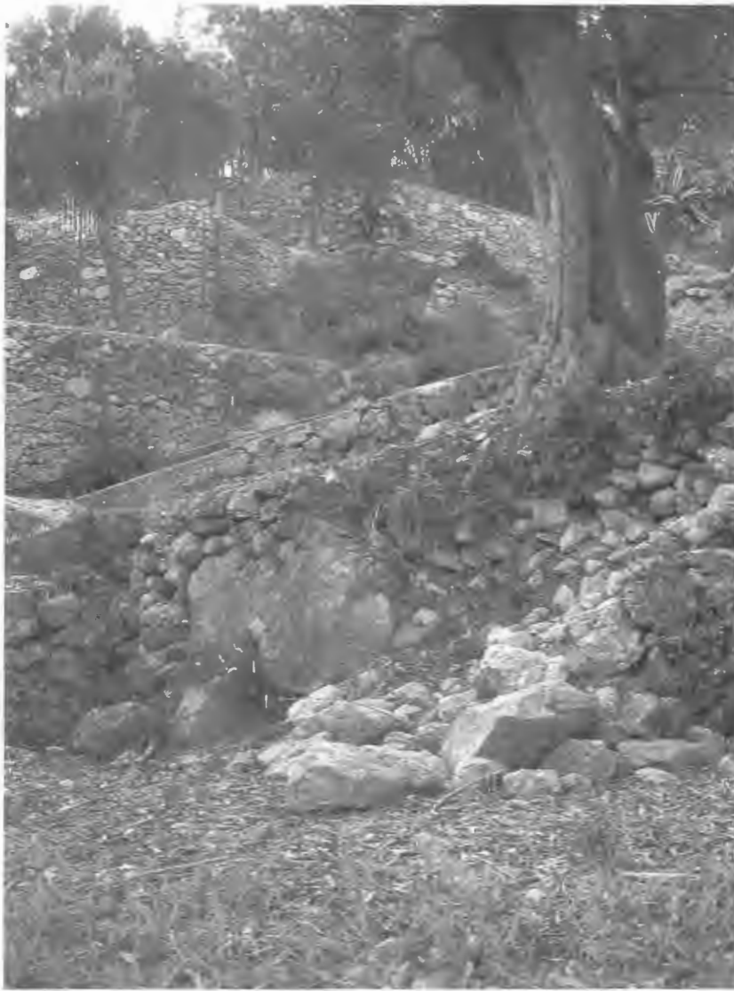
Fig. 1. Vecchi uliveti su terrazzi degradati in primo piano e nuovi muretti a secco con giovani ulivi produttivi in località Punta Crena.
