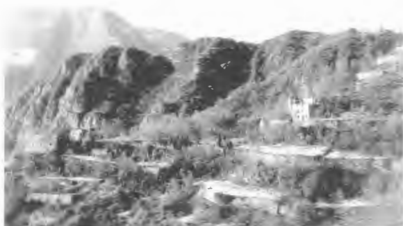
Fig. 4. Ruederi di edifici e versante terrazzato in abbandono presso Col Ventidueore (Valstagna, quota 530 s.l.m.): il degrado nelle porzioni più alte del versante coinvolge ogni elemento del sistema: campi, forme insediative e viabilità, rendendo questi siti pressoché inaccessibili (Foto Varotto, 2000).
