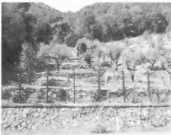
Foto 15. Lungo la strada che attraversa la Valnerina, da Terni verso i Monti Sibillini, si possono vedere alcuni terrazzamenti come quello ubicato presso il bivio per Poggiodomo che ospita un oliveto specializzato. Il terrazzamento, sostenuto da muretti a secco, alti circa 1 m e realizzato con pietre del posto, presenta anche una ridotta area adibita alla coltivazione di piante da frutta ancora di giovane età (Foto Recchi, 2007).
