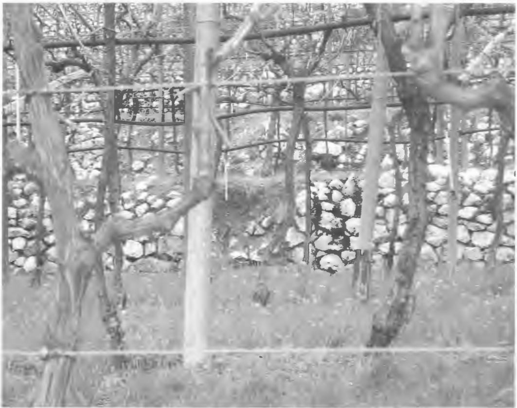
Fig. 3. Terrazzamento in fase di degrado.
