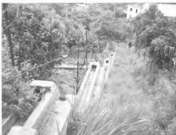
Fig. 7. Santa Teresa di Riva (Messina). Terrazzamento ad agrumeto ripristinato con canali di irrigazione ricostruiti.
