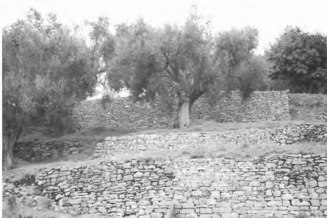
Fig. 2. Pisciotta (Salerno). Az. "Principe di Vallescura". Oliveto terrazzato e muri a secco ripristinati secondo l'antica tecnica.
