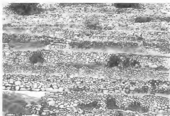
Fig. 3. Particolare di muro a secco in pietra calcarea privo di coronamento, attualmente in abbandono (foto R. Russo).
