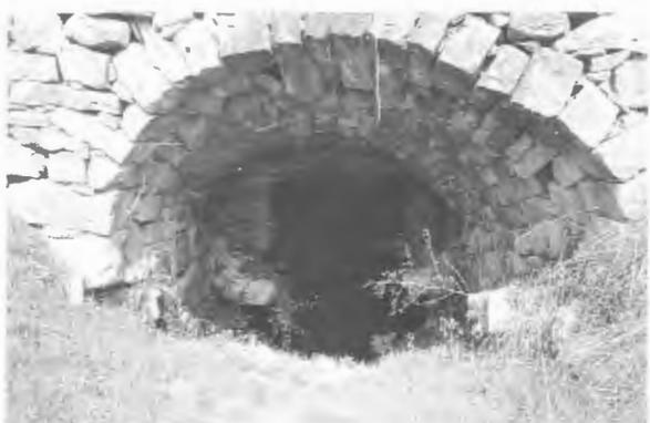
Fig. 2. Arco cavo a tutto sesto con all'interno cisterna per la raccolta dell'acqua (fonte: foto dell'autore).
