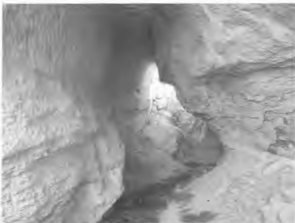
Fig. 5. Sezione di un cunicolo di drenaggio. In evidenza, nella parte superiore, l'originaria conformazione. La morfologia della parte inferiore è stata ampliata e modificata dall'intenso scorrimento idrico e dai crolli.
