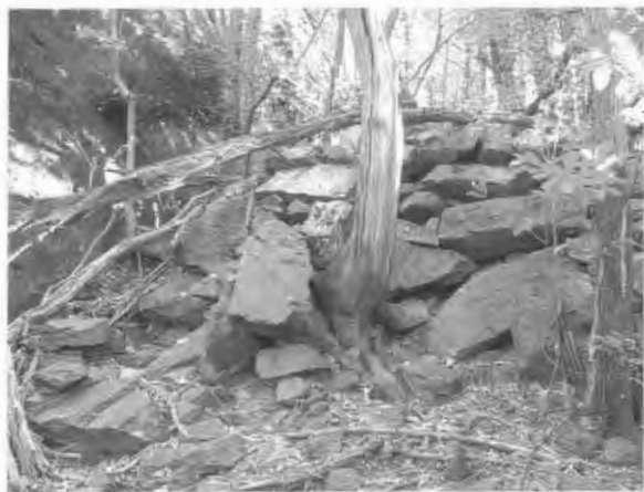
Fig. 2. Area terrazzata per la coltivazione del castagno in stato di fortissimo degrado per le pessime qualità del costruito (foto: L. Bonardi, 2006).
