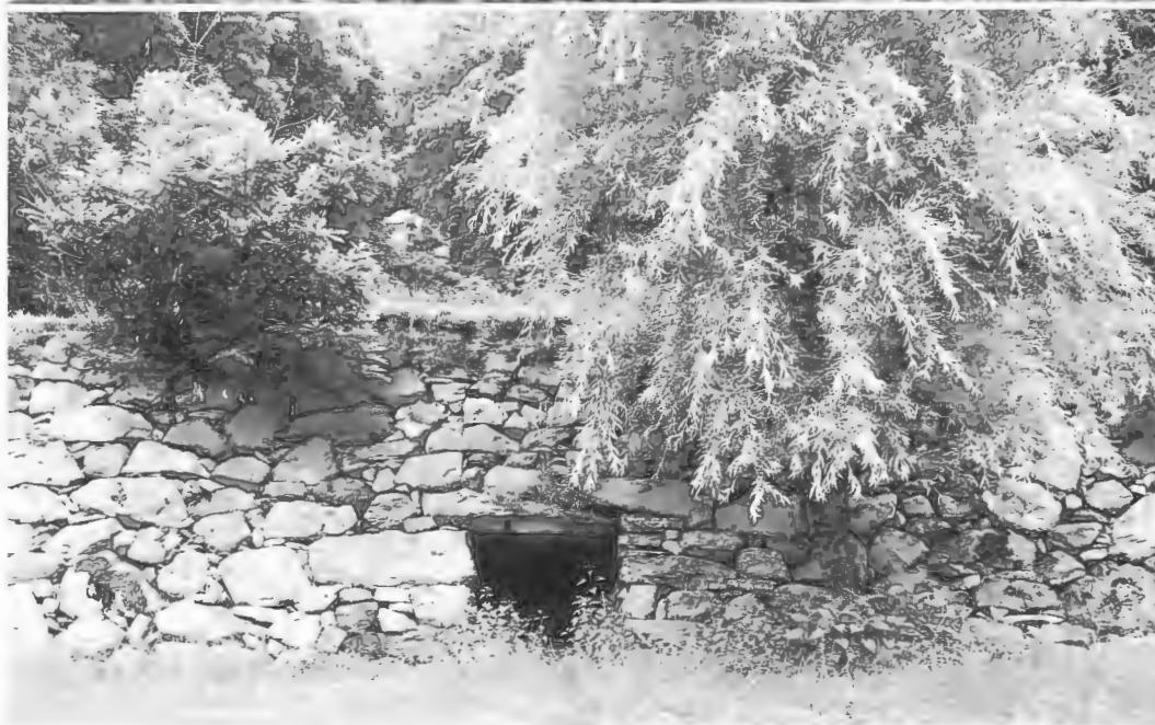
Fig. 7. In alto: nucleo di architetture tradizionali a destinazione mista (stalla, fienile, cantina e deposito attrezzi) in un tratto vitato del versante di Pianazzola. In basso: deposito e ricovero animali ricavato nel muro di sostegno (Pianazzola) (foto: L. Bonardi, 2005).
