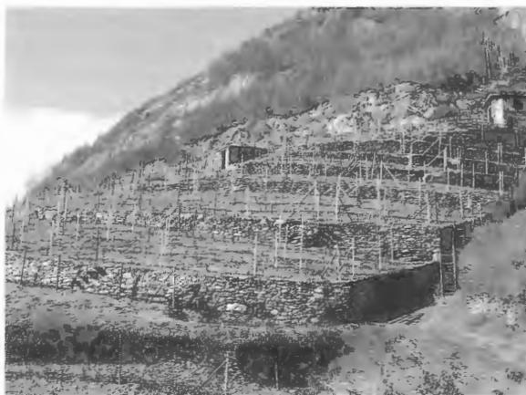
Fig. 6. Chiomonte. Terrazzamenti in ottimo stato di manutenzione coltivati a vigneto, in località Maddalena, alle pendici della frazione Ramats. I vigneti assecondano le curve di livello, e i muretti sono raccordati da gradoni aggettanti, costituiti da lose.
