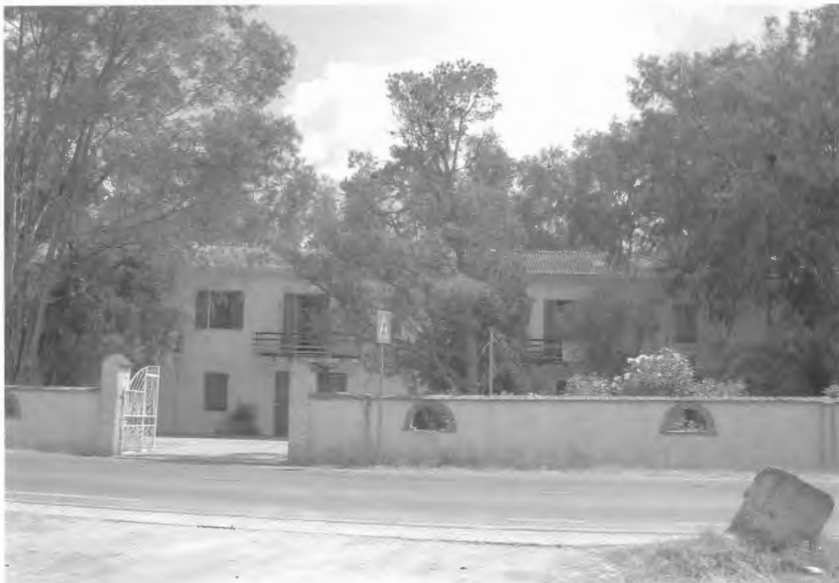
Fig. 1. Il nuovo ingresso delle Terme di San Saturnino (foto M. Sechi Nuvole).
