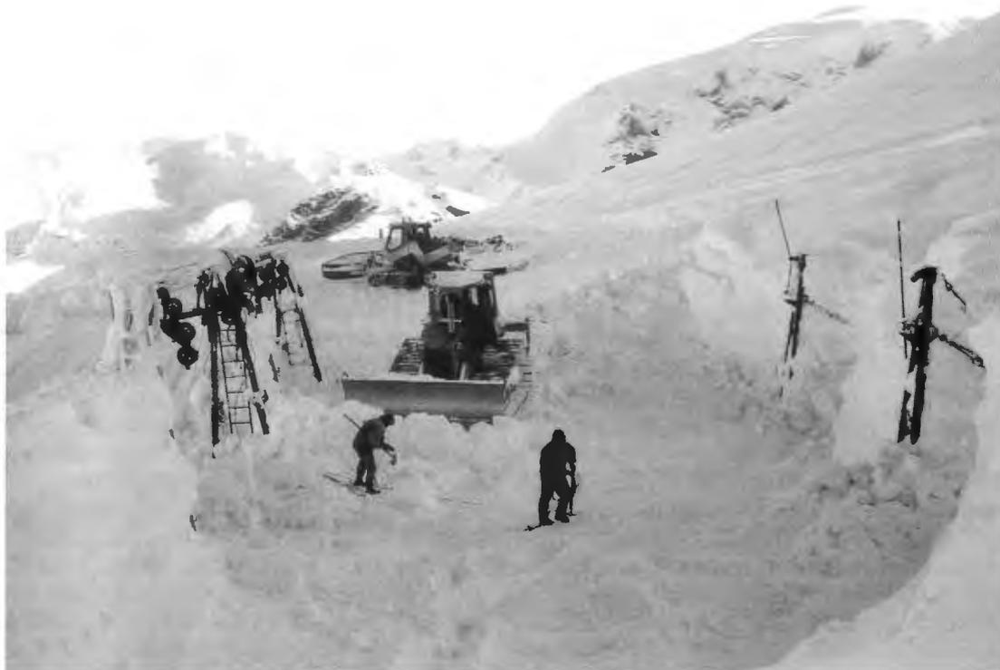
Fig. 6 - Operazioni necessarie a ristabilire la funzionalità degli impianti all'inizio della stagione, che comportano annualmente la rimozione di parte dell'accumulo nevoso.
