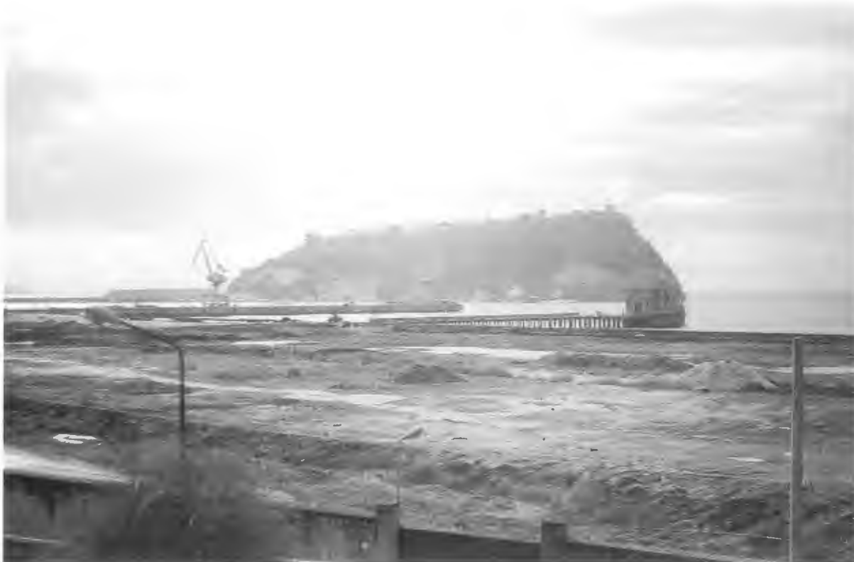
L'area della colmata a mare, i pontili e, sullo sfondo, l'isola di Nisida (foto dell'autore).
