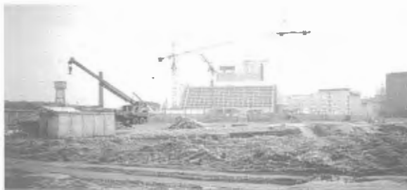
Fig. 3.1 - Il Teatro degli Arcimboldi in Bicocca in corso di costruzione.
