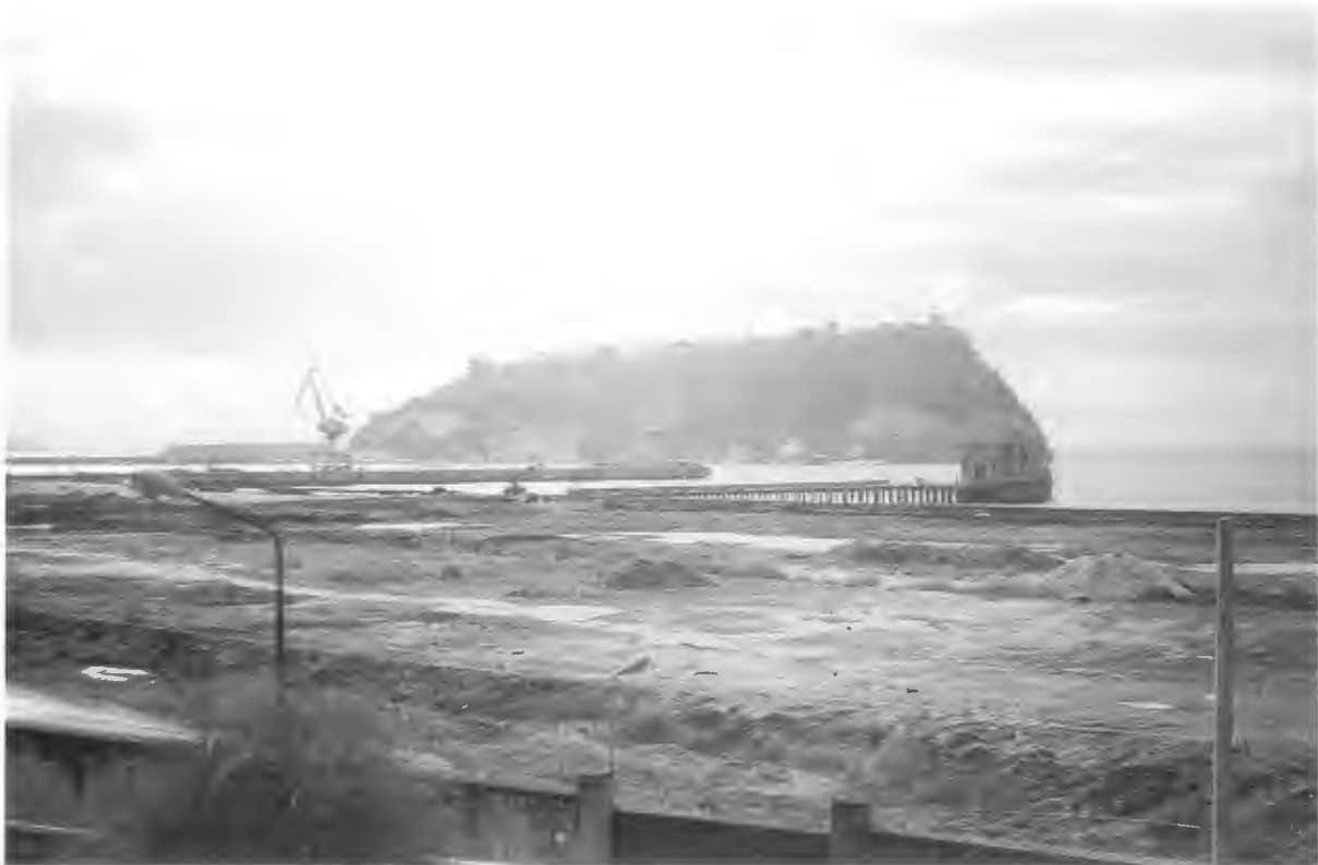
L'area della colmata a mare, i pontili e, sullo sfondo, l'isola di Nisida (foto dell'autore).
