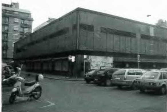
Fig. 7. Piazza del Mercato a Terni, con la struttura al centro (2009).
